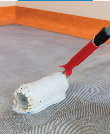
Aplikace Eco Primu T válečkem
