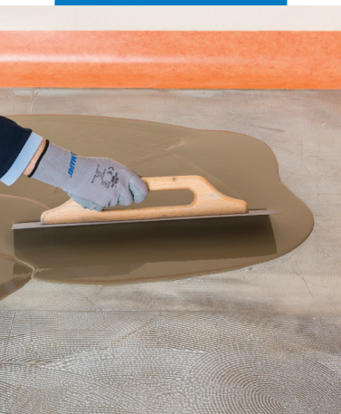
Aplikace Ultraplanu Fast Track kovovou stěrkou
