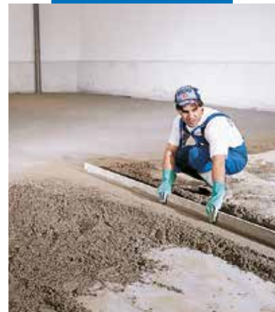
Provádění vodícího pásu
