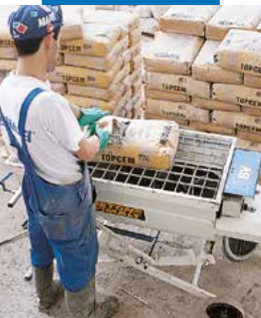
Příprava potěru Topcem v kontinuální míchačce
