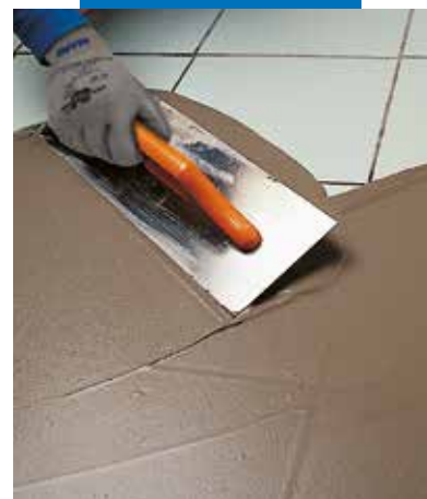
Vyrovňávání stávající podlahy Nivorapidem
