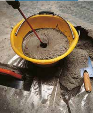
Míchání Nivorapidu mechanickým míchadlem
