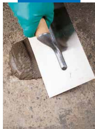
Oprava vodorovné hrany Nivorapidem
