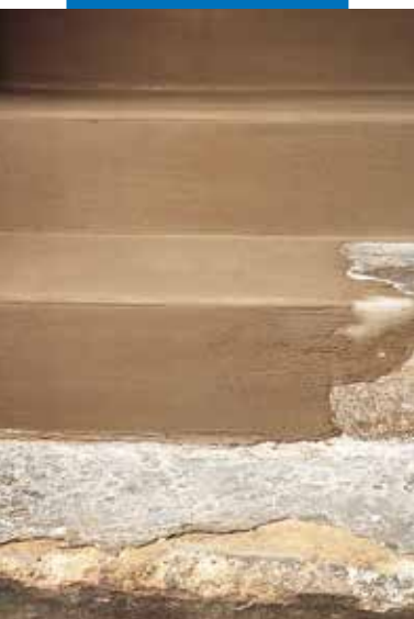
Schody před a po aplikaci Nivorapidu
