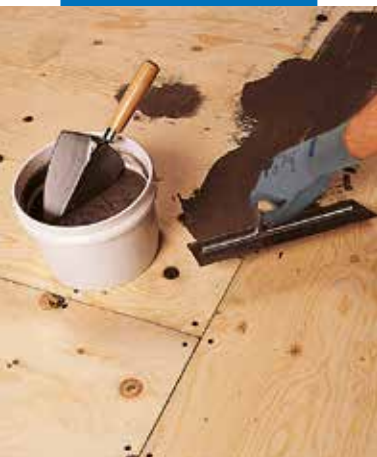
Výplň spár podkladu z překližky směsí Nivorapid+Latex Plus
