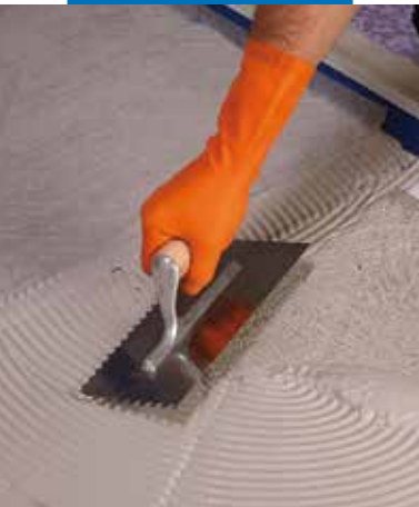
Nanášení první vrstvy Monolasticu vyztužená Mapetex Sel na nový potěr
