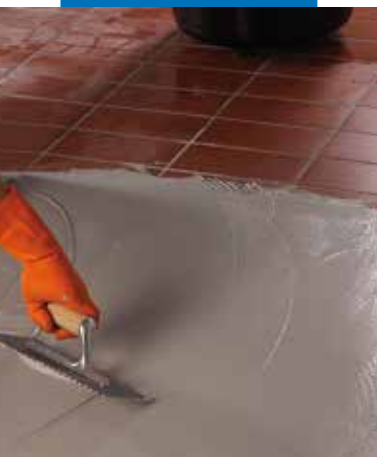
Nanášení druhé vrstvy Monolasticu na Mapenet 150
