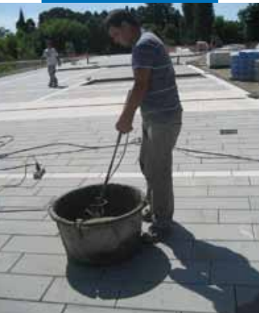
Příprava Mapestone PFS 2 s vodou s použitím míchacího nástavce nebo míchačky na maltu
