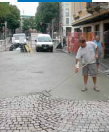
Nanášení namíchané směsi na navlhčenou dlažbu
