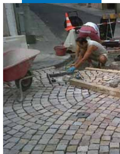
Ukázka dlažby z kostek ve vzoru "paví ocas"
