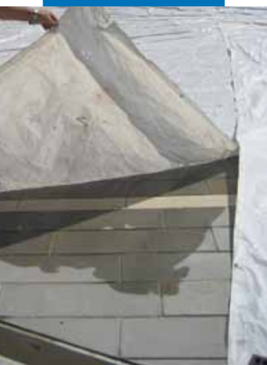
Ukázka ochrany čerstvě dokončené dlažby
