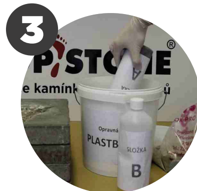
Nalijeme složku A a složku B do kbelíku a důkladně promícháme přiloženým dřevěným míchadlem (cca 3minuty)
