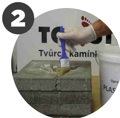
Přiloženým brusným papírem očistíme opravovaný povrch, následně přiloženým štětcem očistíme povrch od prachu
