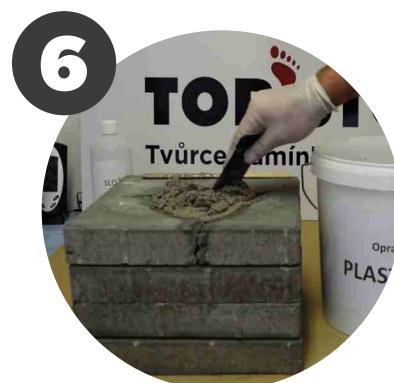
Připravenou směs nanášíme a důkladně uhladíme přiloženou stěrkou či ocelovým hladítkem (pracujeme rychle, směs se musí zpracovat do 30minut od namíchání)
