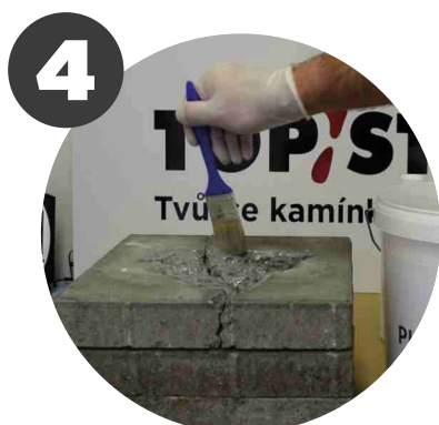
Přiloženým štětcem natřeme smíchanou hmotu na opravovaná místa
