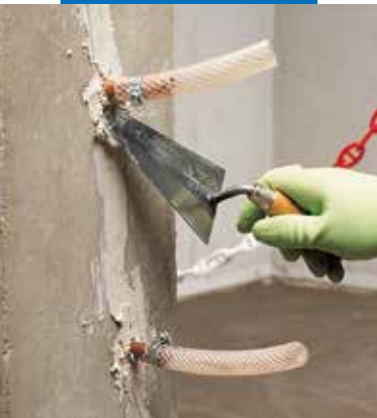
Upevňování injektážních trubic a těsnění trhlin pro zpevnění konstrukce
