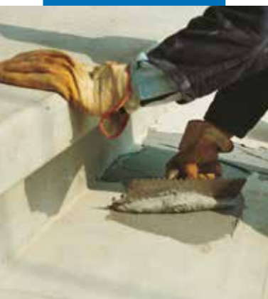
Aplikace Adesilexu PG1 zubovou stěrkou pro konstrukční lepení schodů z prefabrikovaného betonu
