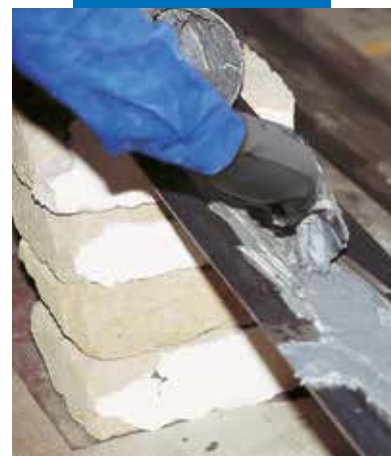
Aplikace Adesilexu PG1 na kovový plát
