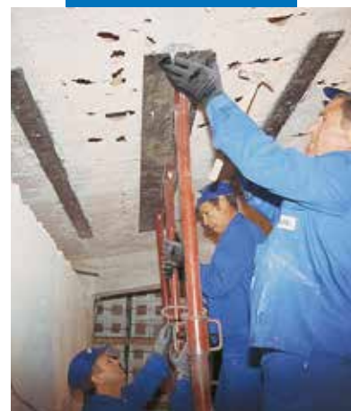
Přípevnění kovového plátu jako konstrukční výztuž
