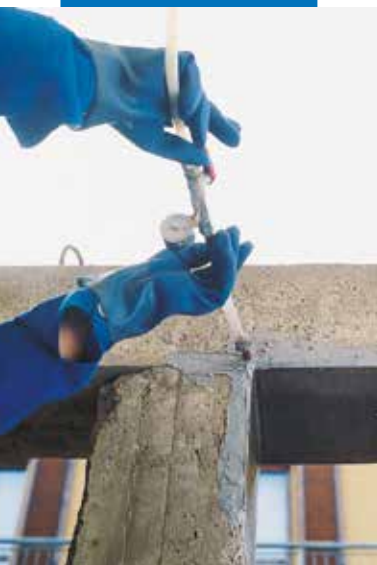
Sloup ošetřený výrobkem Adesilex PG1
