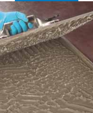
Ověření smočení rubové strany dlaždice tmelem
