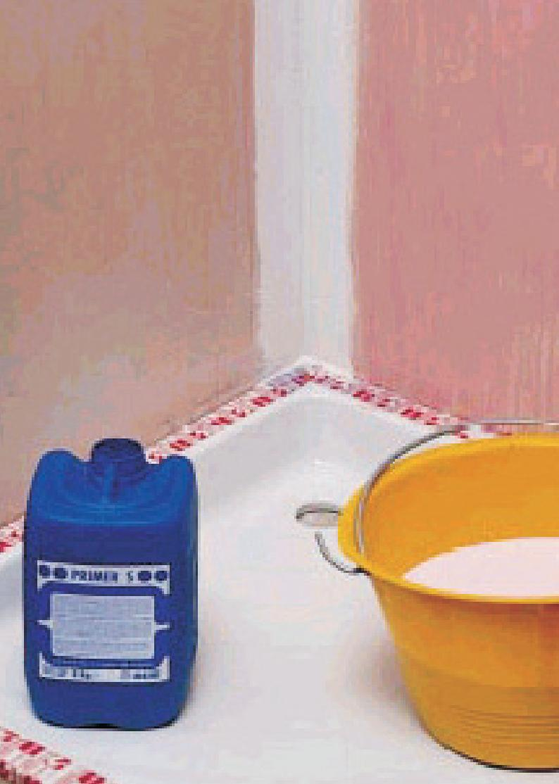
impregnační účinek, může být po vyschnutí již naneseného podkladního nátěru (cca 1–2 hodiny v závislosti na klimatu a savosti) proveden druhý i třetí nátěr. Je nutno zabránit vytváření louží. Po uplynutí dostatečně dlouhé doby, až nátěr vyschne, může být provedeno tmelení nebo lepení.
