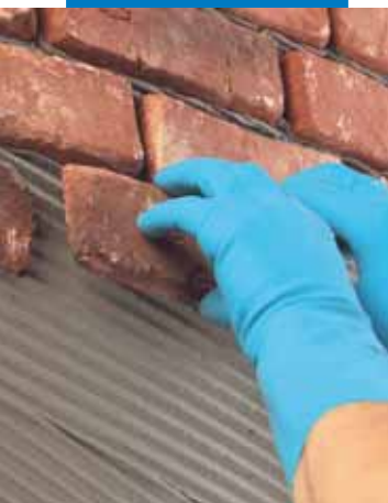
Instalace obkladových pásků
