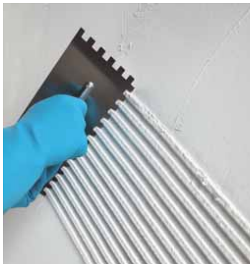
Diagonální nanášení lepidla Fix & Grout Brick bílého zubovou stěrkou č. 10
