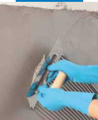
Nanášení Fix & Grout Brick šedého zubovou stěrkou v diagonálním směru
