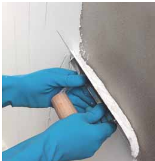
Nanášení základní tenké vrstvy na podklad
