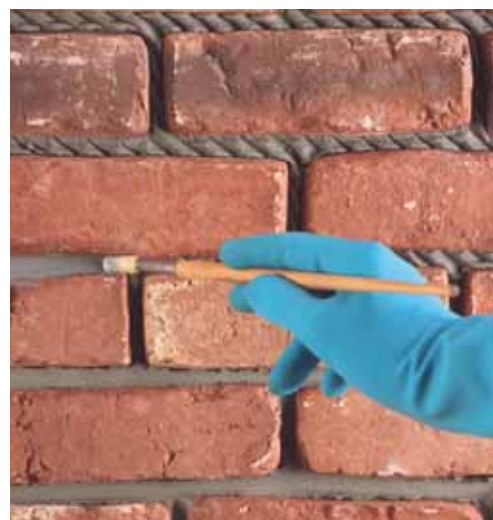
Vyhlazení spáry vlhkým štětcem
