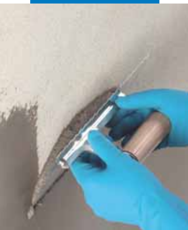
Nanášení tenké základní vrstvy Fix & Grout Brick šedého
