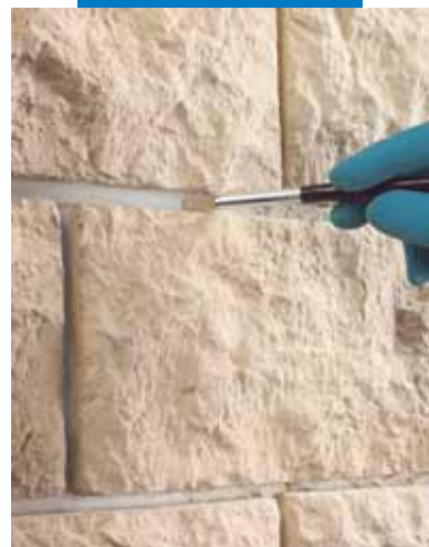
Vyhlazení spáry vlhkým štětcem
