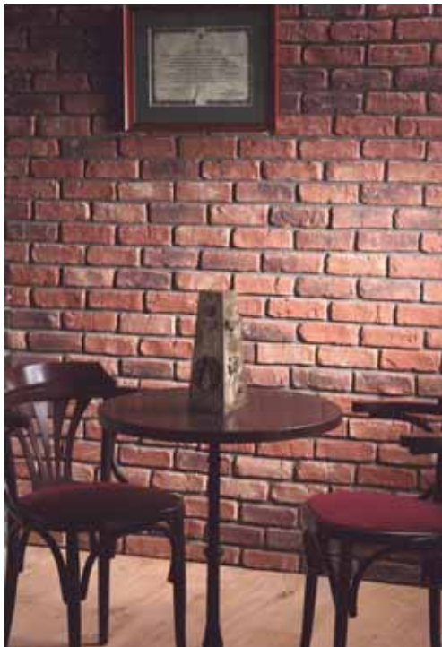
Příklad pokládky dekorativních obkladů z vylehčeného cementového konglomerátu v interiéru
