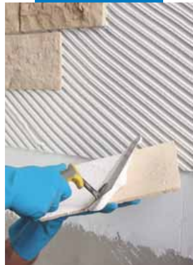
Nanášení lepidla na rubovou stranu obkladového prvku
