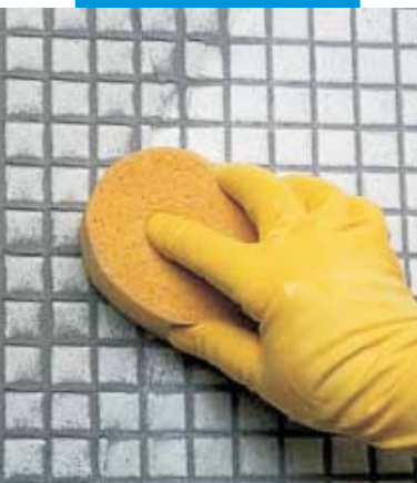
Dokončení povrchu obkladu ze skleněné mozaiky
