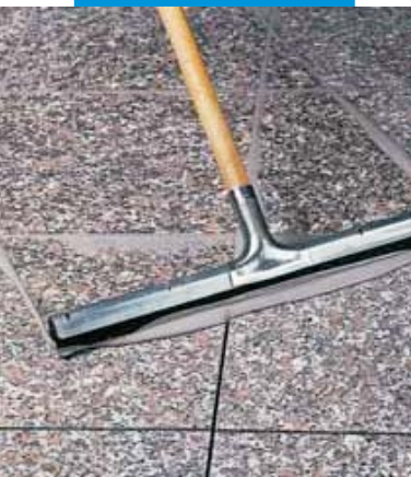
Spárování povrchu žulové dlažby stěrkou na násadě
