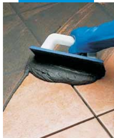
Spárování jednou pálené dlažby stěrkou
