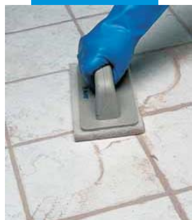
Dokončení povrchu houbou Scotch-Brite®
